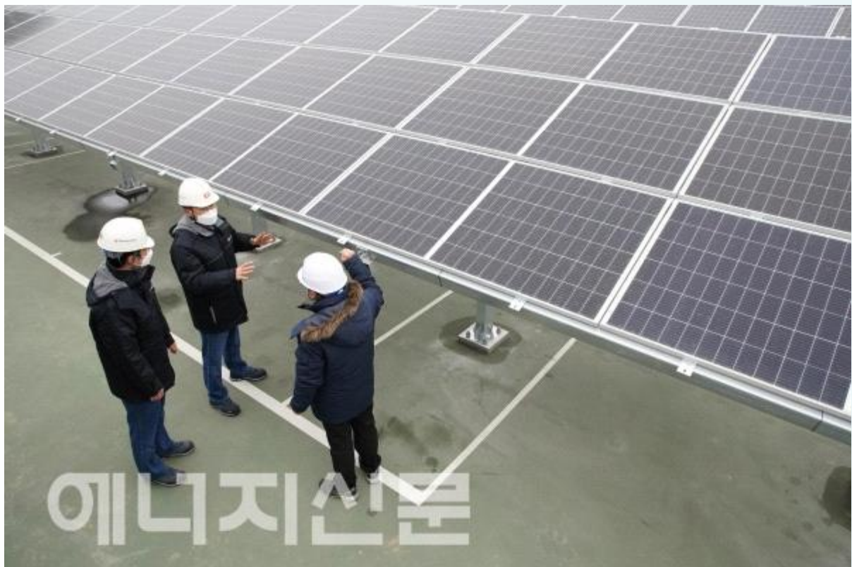
▲ E1 관계자들이 인천 LPG 저장기지 내 설치된 태양광 패널을 살펴보고 있다.
